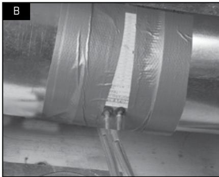
**1** Pour ce poste de mesure des débits, coupez le conduit et placez le poste entre chaque section de conduit. Assurez-vous que la flèche de sens de l'air du poste de mesure des débits pointe dans le sens du débit d'air. Fixez le poste de mesure des débits avec du ruban adhésif.
