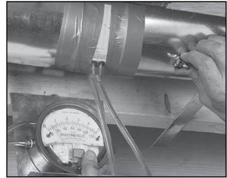
**3** Réglez le registre « Supply Air Out » (sortie de l'air fourni) de façon à obtenir le débit d'air désiré. Suivez les étapes précédentes afin de régler le registre « Exhaust Air Out » (sortie de l'air vicié) au besoin.
